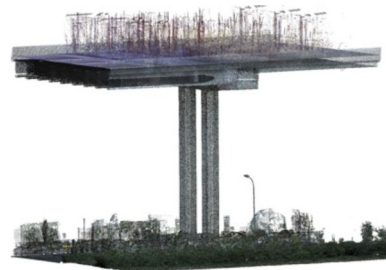
图3 公路桥梁原始扫描点云
